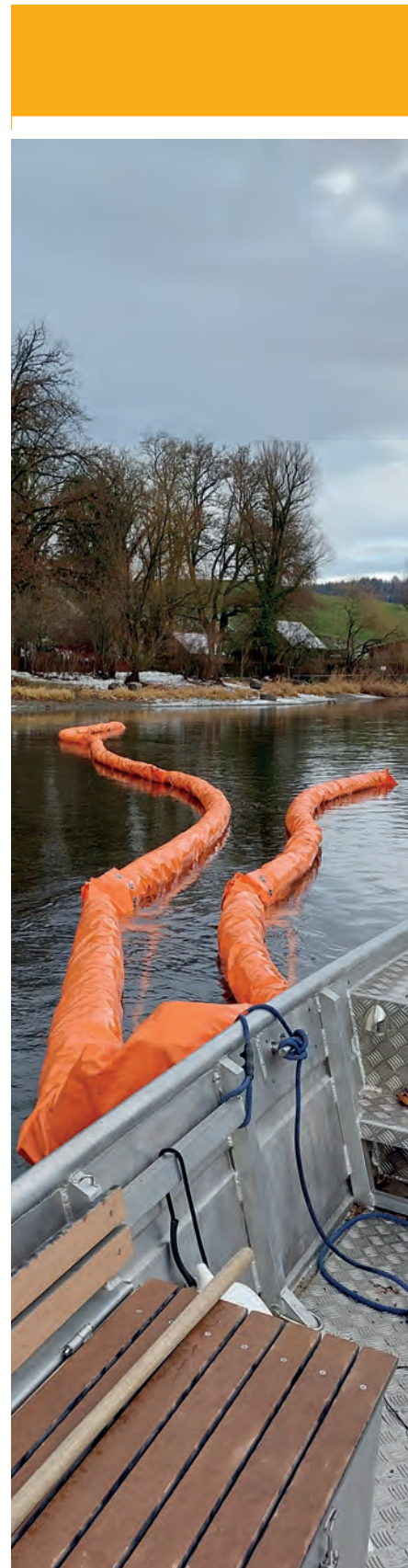
Öisperre setzen, SH POWER
